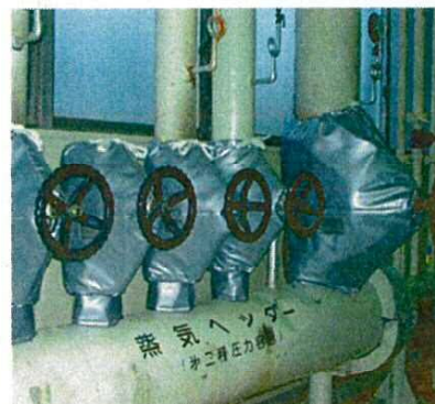
写真2 未保温弁周り配管箇所
