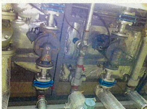
⑤ 温水ポンプ部の露出状況
