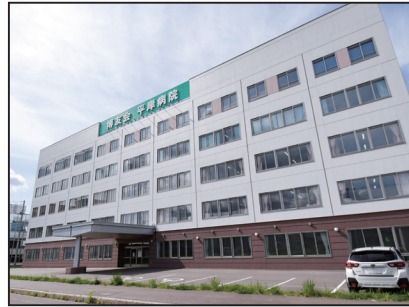
平岸病院 新病棟
