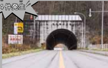
● 鮫淵トンネル内 ●
