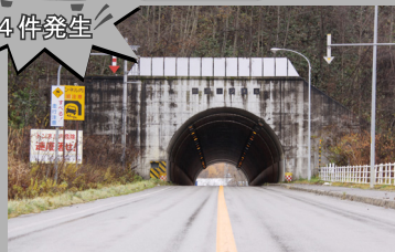
● 鮫淵トンネル内 ●
