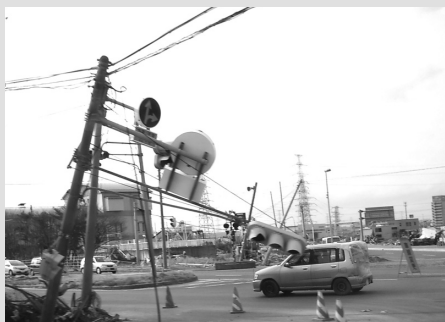
▲信号が倒壊し交通システムが不能に…。
