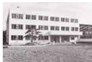
▲S58年校舎完成。S59年体育館新築工事
