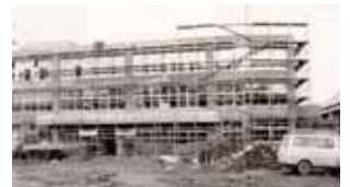
▲校舎改築工事(S58年)
