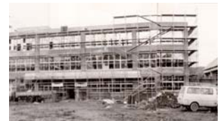
▲校舎改築工事(S58年)
