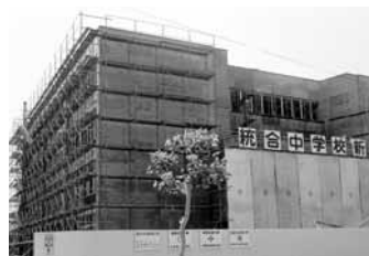
▲昭和51年建設中の校舎
