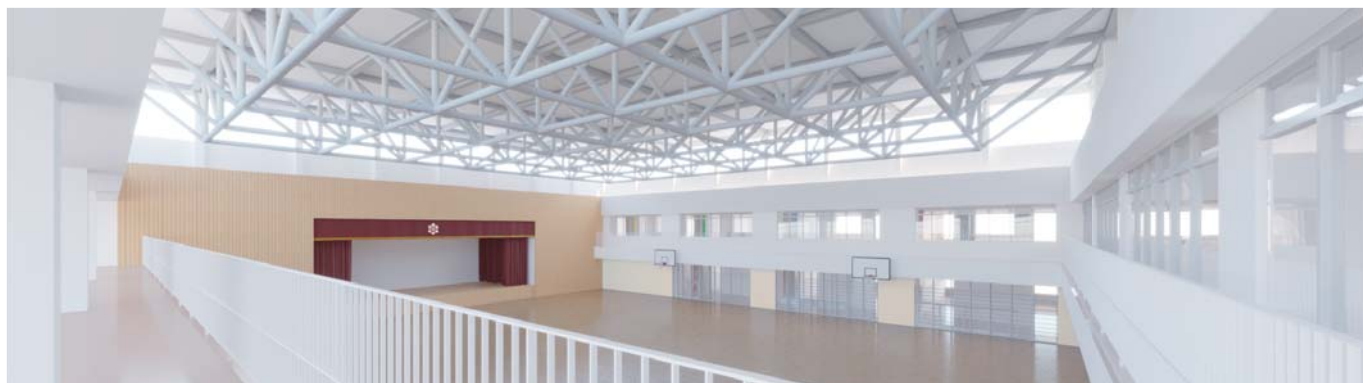
3面ハイサイドライト（高窓）による採光で日中の照明負荷を低減。
