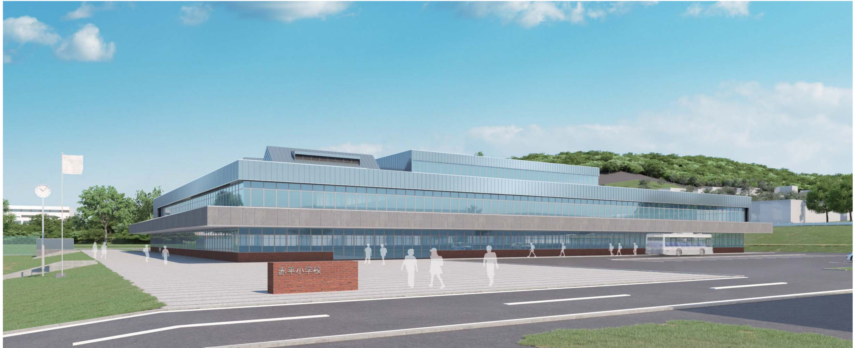
周辺環境に調和する2階建て低層ボリューム。大きな庇は子どもたちや地域住民を迎え入れる。腰壁や校名板は、まちに馴染むレンガを使用。
