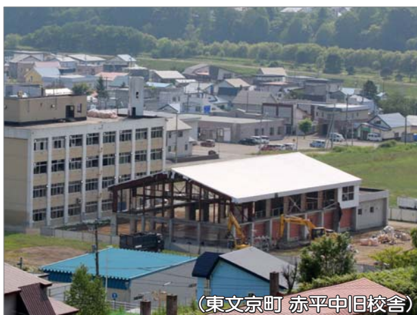
赤平中学校旧校舎が解体中 8/6
