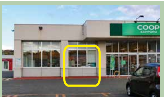
建物に向かって左側の玄関
