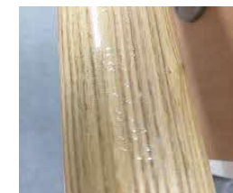
⑦手すりに点字シール
