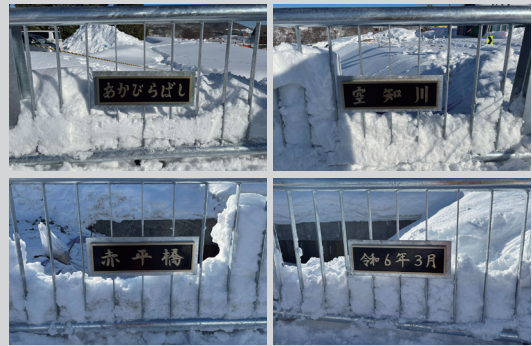
橋に向かって左側と右側に橋名板が設置されました。
