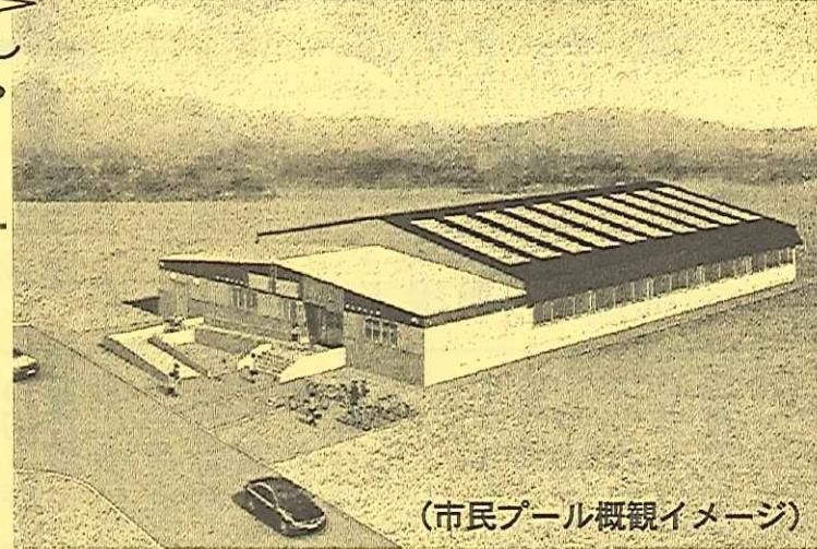
この度の議会にて、市民プール建設工事契約の締結が提案され、可決されました。よって、工事が始まり、来年の3月11日までの期間で、建設が進められます。工事内容は、鉄骨造1棟1階建、延べ床面積958.9m<sup>2</sup>、一般用プール（水深110~120cm）25m×5コース、小学校低学年用コース（水深70cm）25m×1コース、幼児プール（水深50cm）4m×13mでFRP製水槽です。その他、安全に配慮したバリアフリー、体温を保つための採暖スペース、カギ付きロッカーの設置、自然光による水温上昇の省エネ対策、加温式のシステム導入により気温が低いときも、大変快適なスポーツ環境、健康促進の場になることと思います。
